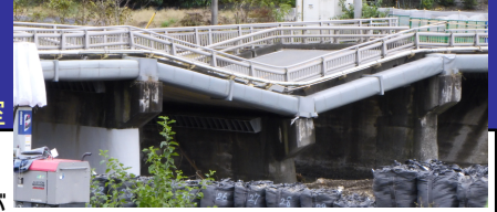
令和元年台風19号による洗掘被害 (国道20号線 法雲寺橋)
