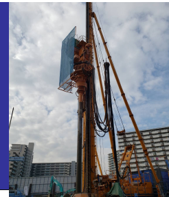
締固め砂杭工法 現場 (2020撮影)
