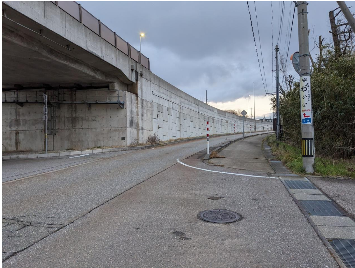
橋台を含むテールアルメ擁壁の全景
