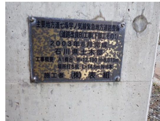
橋台の銘板（2003年8月竣工）
