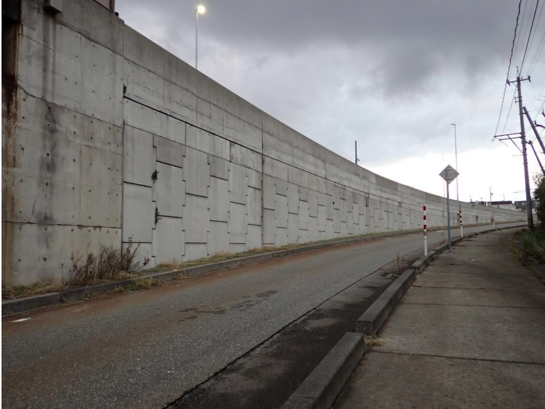
道路南側のテールアルメ擁壁
