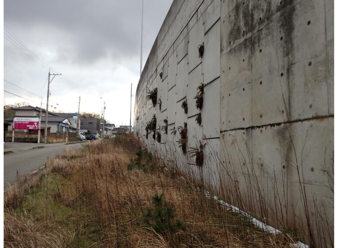
道路北側のテールアルメ擁壁
