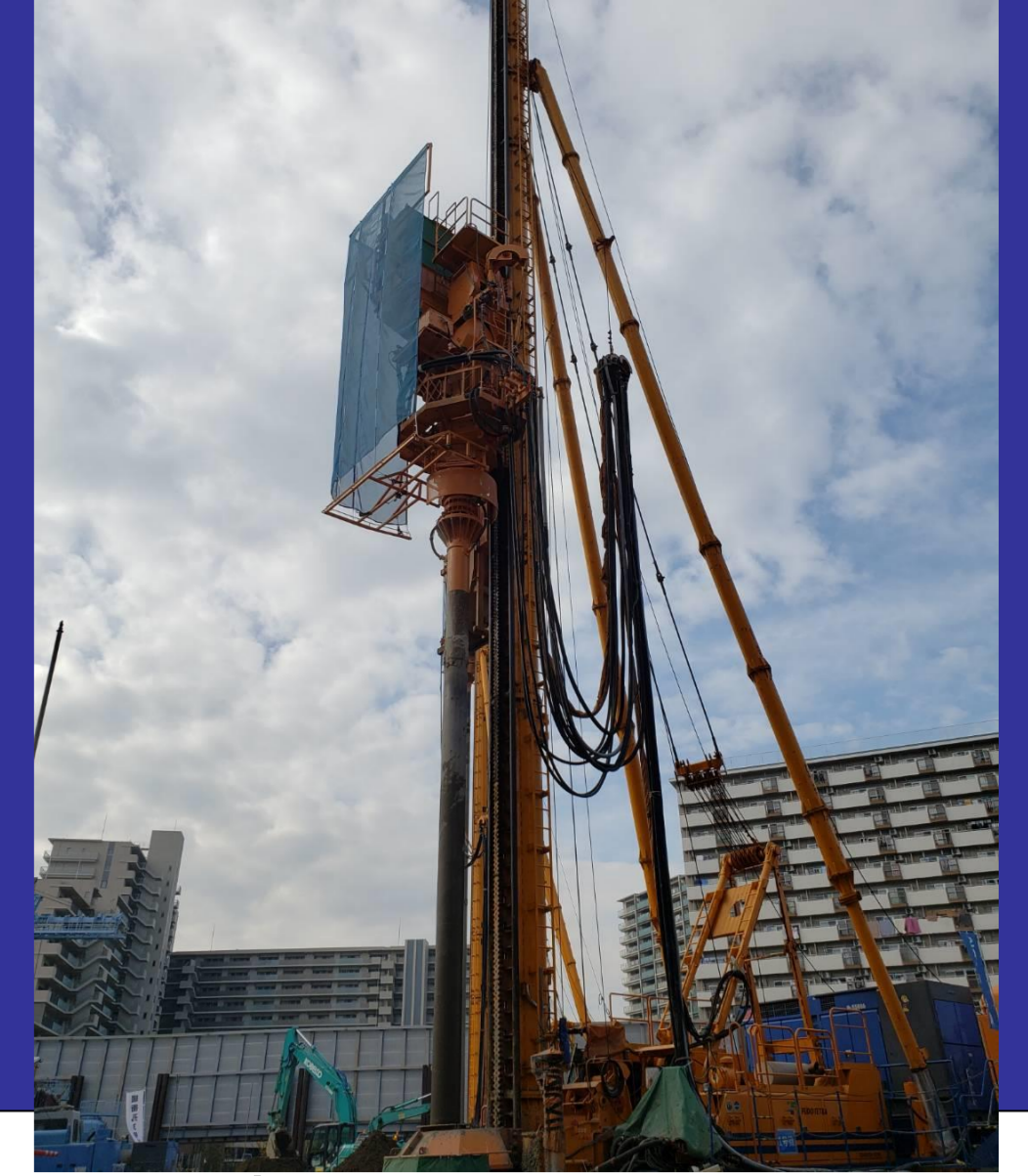
締固め砂杭工法 現場 (2020撮影)
