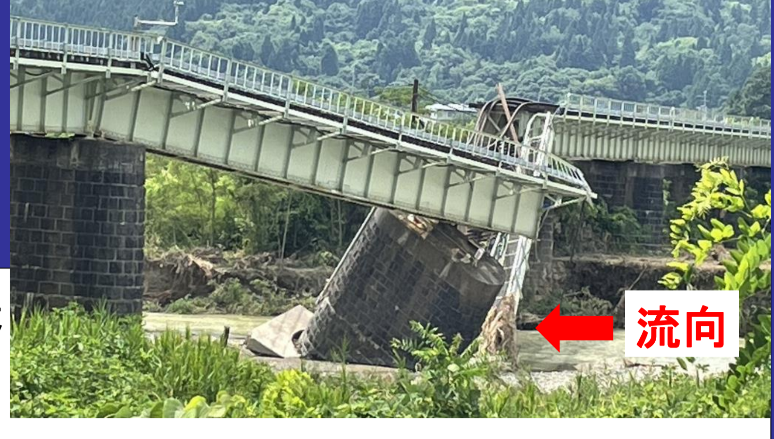
令和4年8月に中規模出水で被災した濁川橋梁(JR磐越西線)
