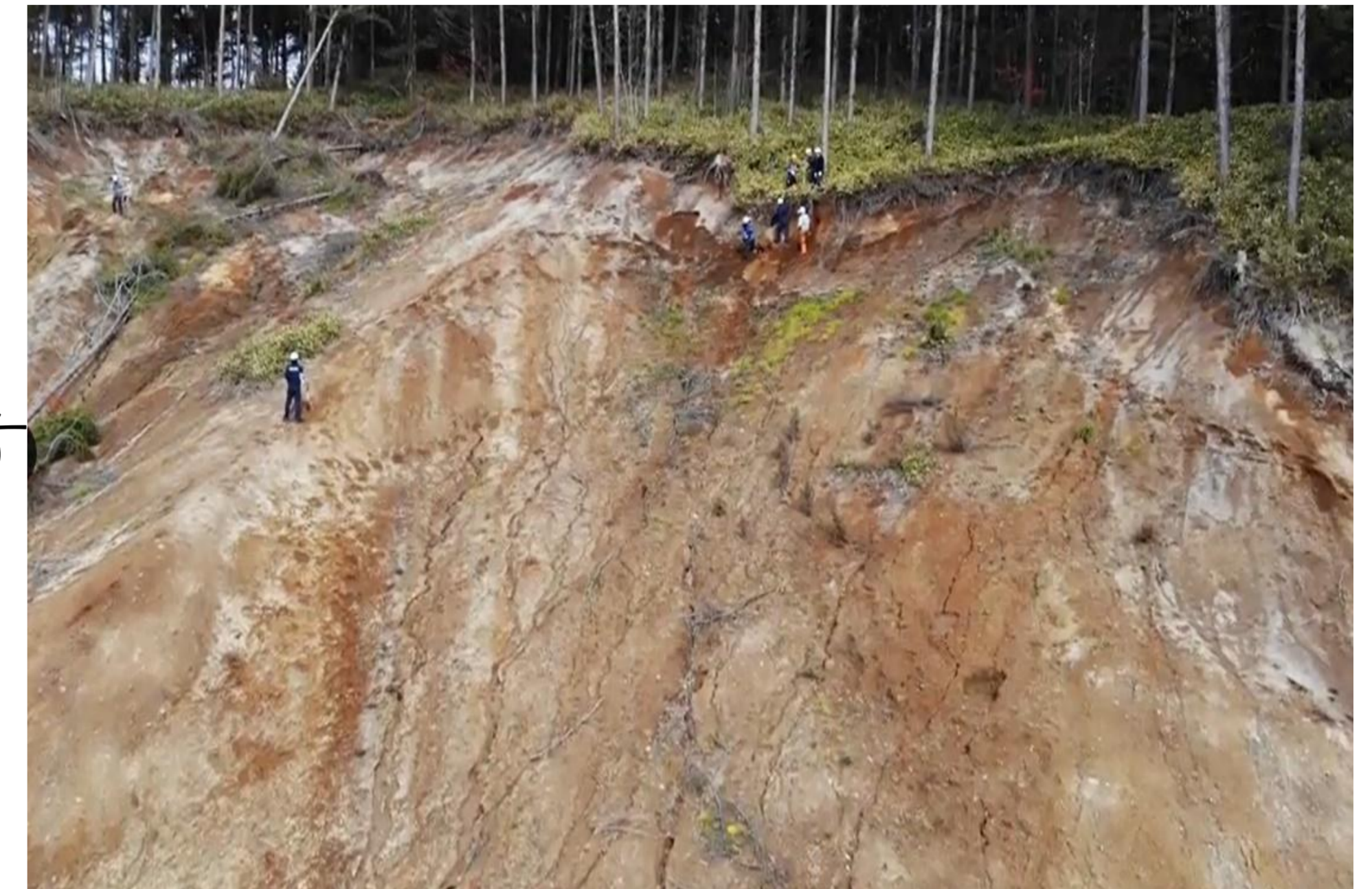
桜丘地区での崩壊の様子
