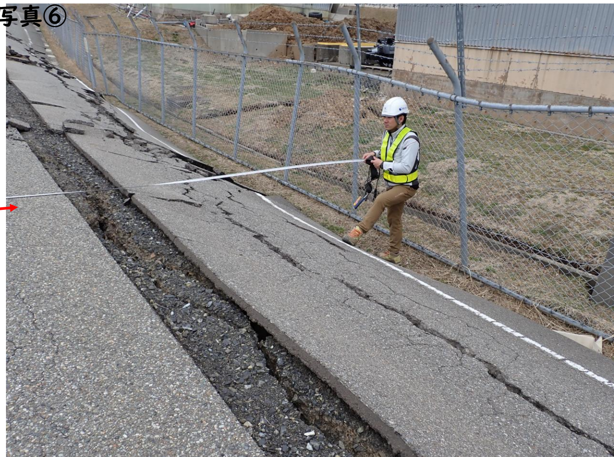
沈下量は最大1.5m程度
