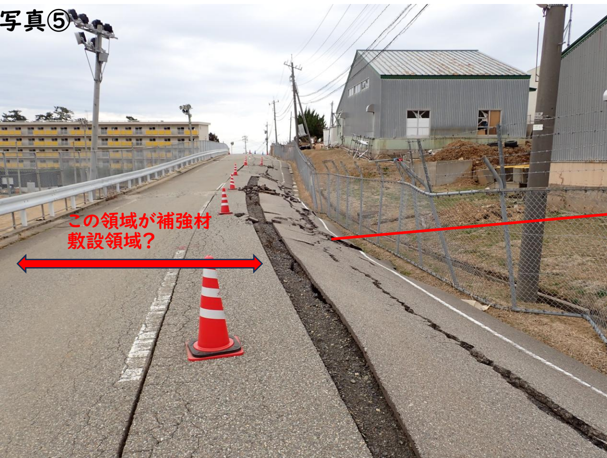
背面盛土の沈下状況
