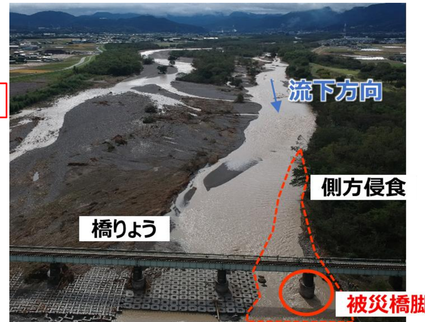
左図: 遅れ変位のメカニズム (図解、Suffusion後の交通荷重により体積減少) 右図: 遅れ変位の関連が疑われる洗掘被災事例 (JR八高線神流川橋りょう)
